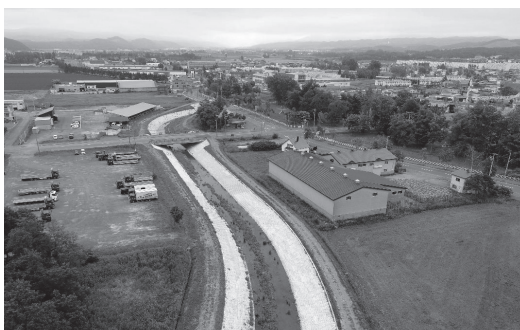
利根別川 広域河川改修工事(利根別川地区)
