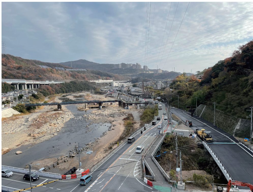
生瀬トンネル（終点側）
