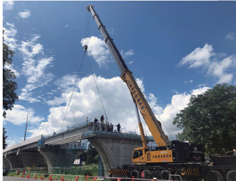
国道161号小松拡幅北小松高架橋の上部桁架設状況
