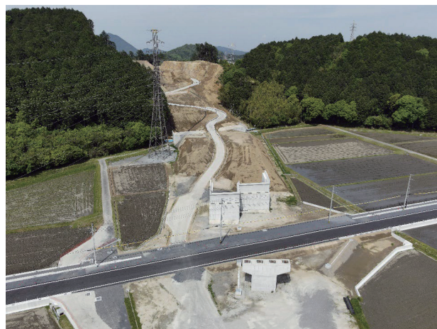
掘削工事が進む国道1号栗東水口道路上砥山地区
