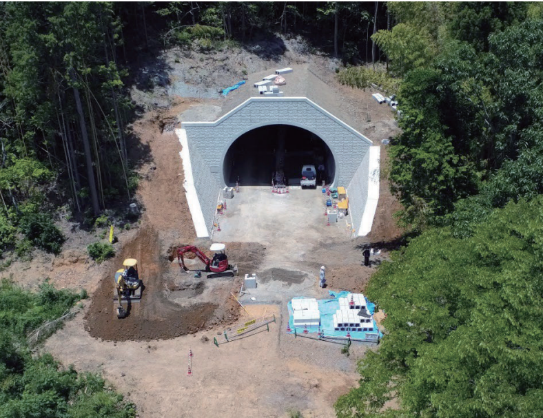
貫通した国道8号米原バイパスの彦根トンネル
