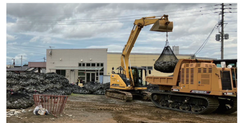
資材運搬状況（7 月 13 日撮影）
