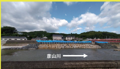
復旧完了（7 月 16 日 9 時 00 分撮影）
