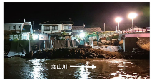
復旧状況（7 月 11 日夜間撮影）
