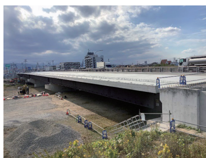
豊中観音寺拡幅本山橋床版工事
