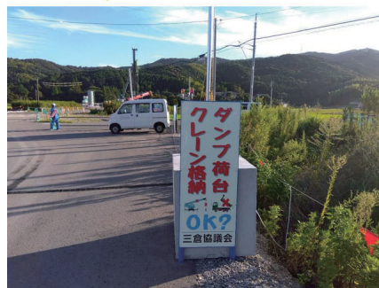
架空線接触事故防止ゲート
