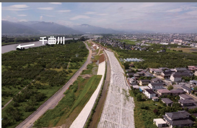
【写真①】 粘り強い河川堤防の整備（立ヶ花～村山橋の間）
