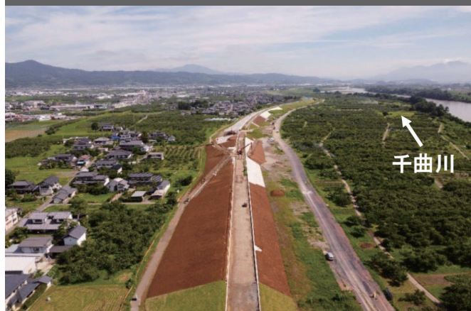
【写真①】 粘り強い河川堤防の整備（立ヶ花～村山橋の間）
