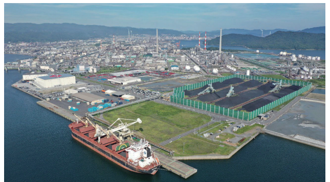
写真 3 新南陽地区岸壁の整備状況 (R3.7.21 撮影)
