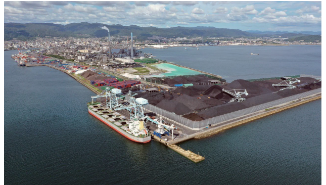
写真 2 徳山地区岸壁の整備状況 (R5.8.3 撮影)
