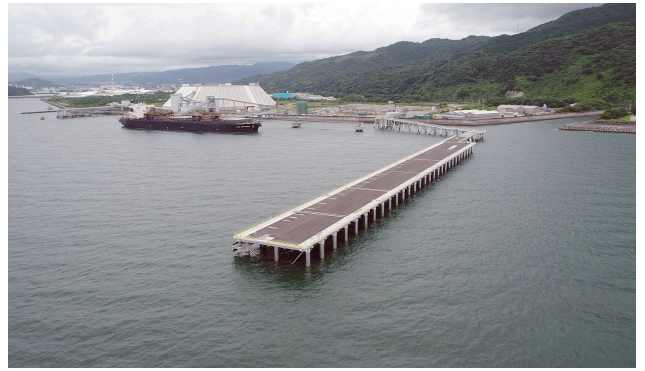
写真 1 下松地区栈橋の整備状況 (R6.7.18 撮影)
