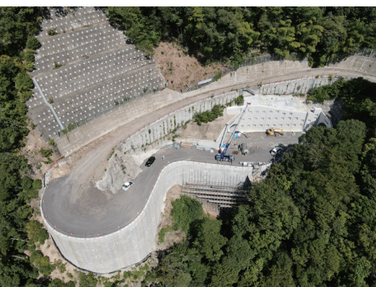
(株)浅田組 山鳥坂ダム見の越工事用道路工事
