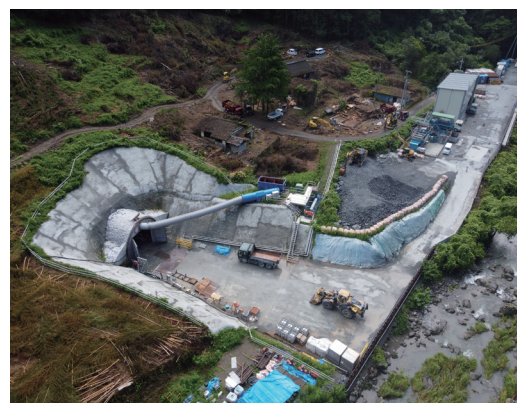
鹿島建設(株) 山鳥坂ダム仮排水トンネル工事
