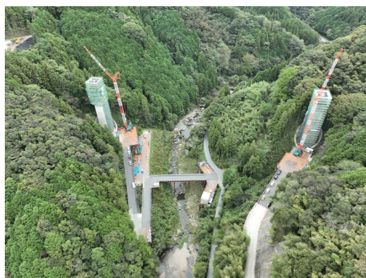
(株)大本組 山鳥坂ダム新入船橋橋脚工事
