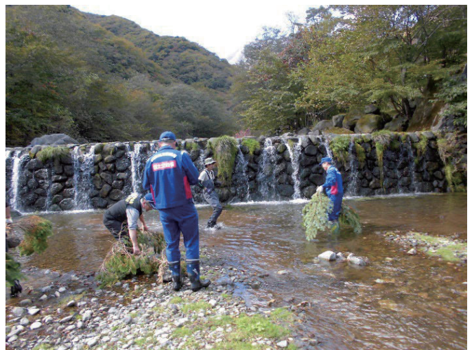
土砂と木の枝で作成したイワナの住処の設置の様子
