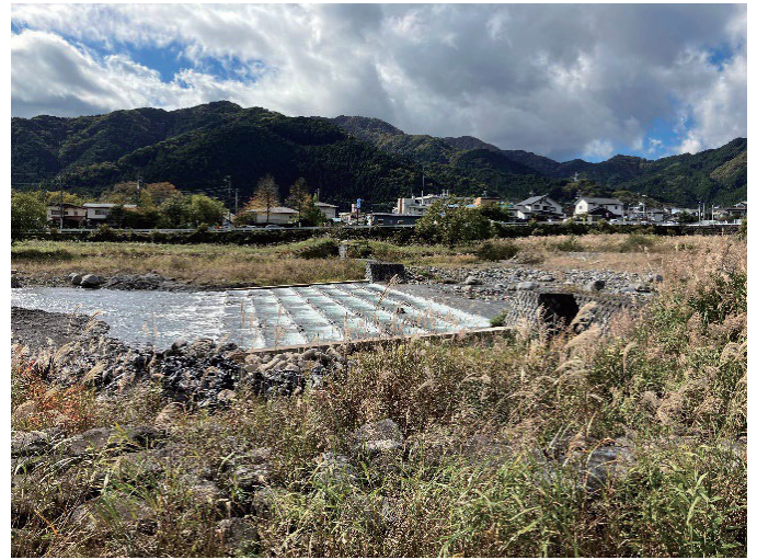
大谷川(だいやがわ)における床固工と川幅一杯の全断面魚道
