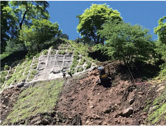
野門山腹工での無人バックホウによる掘削
