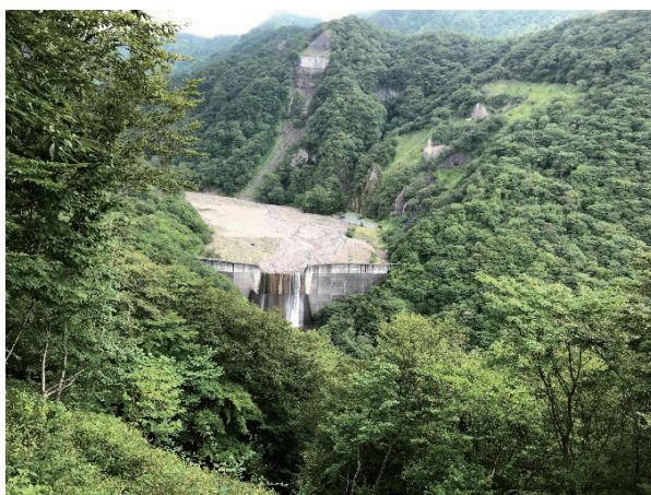
日光砂防の守りの要、日向(ひなた)砂防堰堤と稲荷川山腹工
