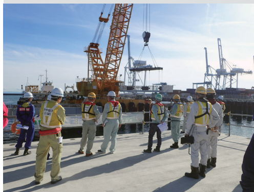
清水港海づり公園施設整備工事
