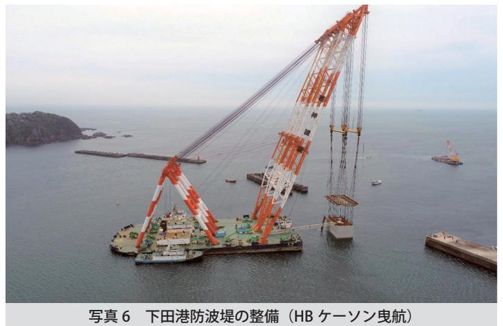
写真6 下田港防波堤の整備（HBケーソン曳航）
