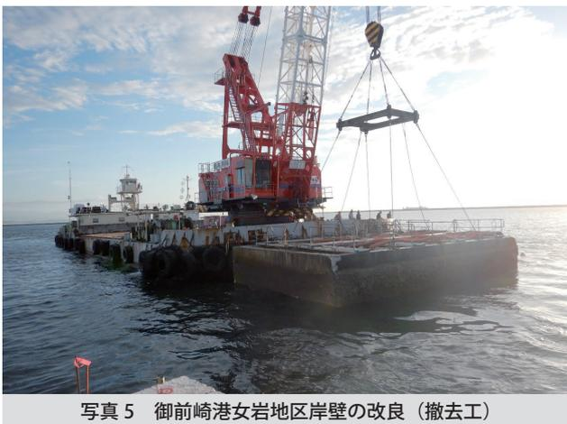
写真5 御前崎港女岩地区岸壁の改良（撤去工）
