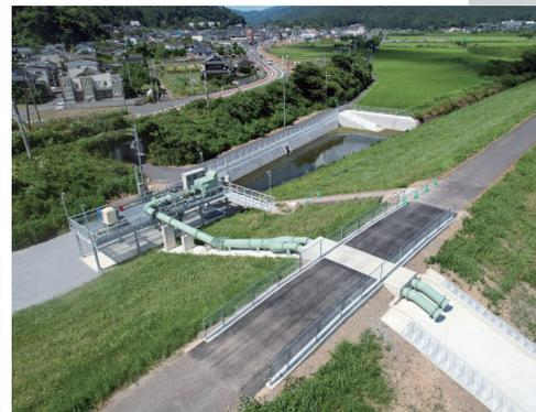
写真-6 マスプロダクツ型排水ポンプ設備
