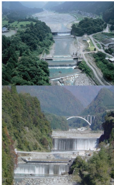
国内最大級の貯砂量 500 万 m 3 を誇る本宮砂防堰堤（重要文化財）
