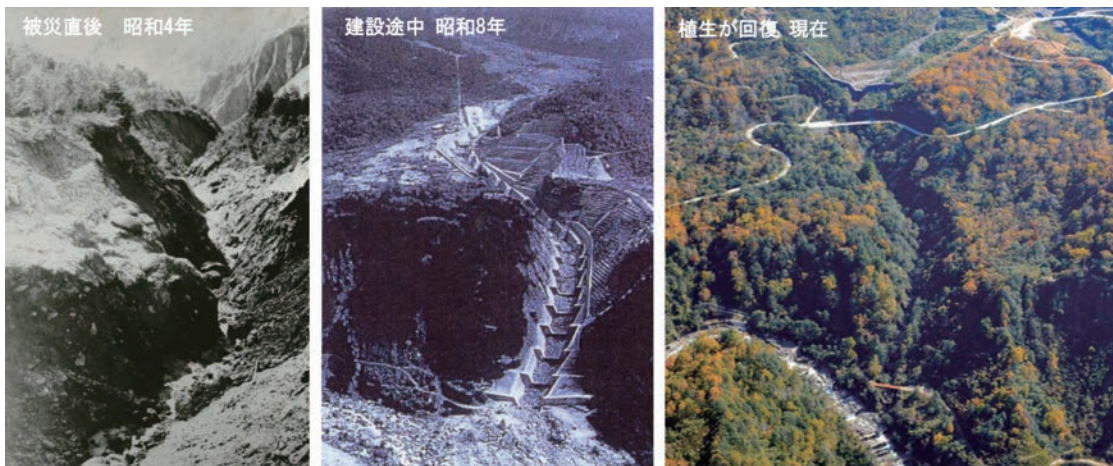
23基の砂防堰堤からなる泥谷砂防堰堤群（重要文化財）
