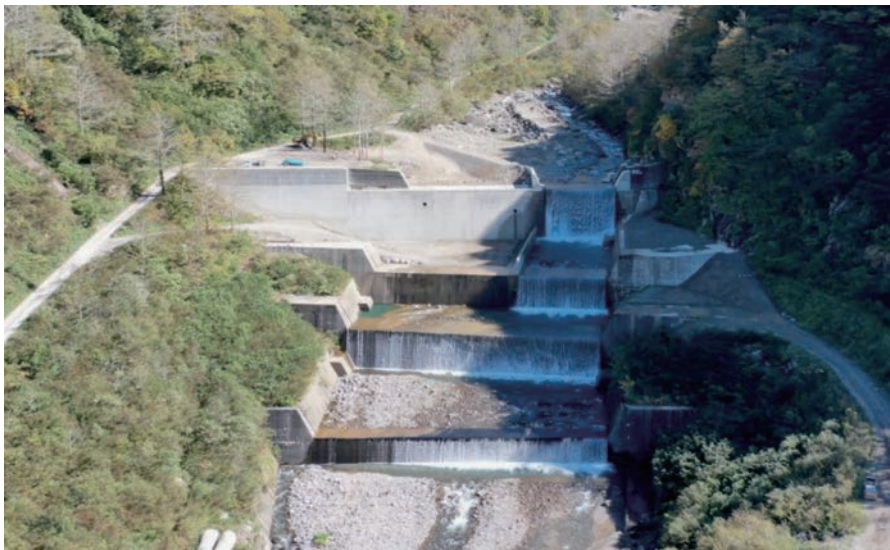
ライフサイクルコストを考慮した砂防施設の長寿命化対策（水谷第3号砂防堰堤改築）
