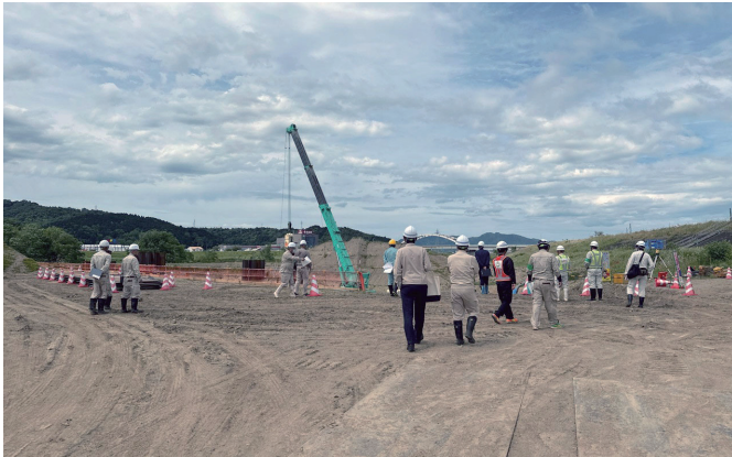
安全パトロール実施状況（現場確認）
