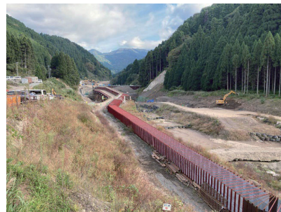
写真-3 分水施設施工状況 (令和6年10月)
