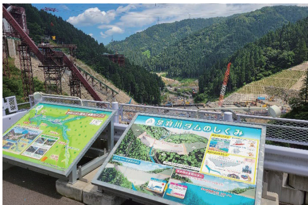
写真-8 ダム本体建設展望台
