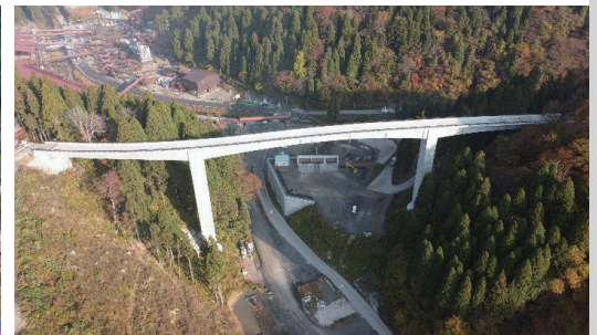
写真-4 完成した付替県道11号橋
