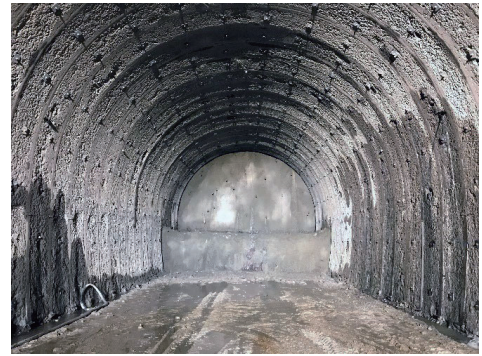
写真-2 トンネル約4km地点 (令和6年10月)
