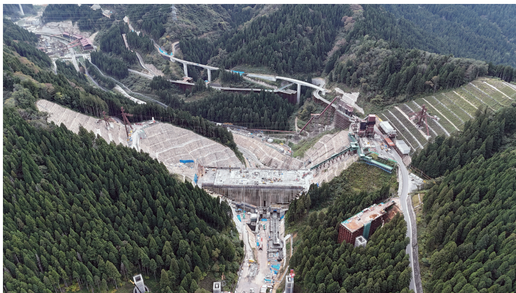
足羽川ダム（下流より）
