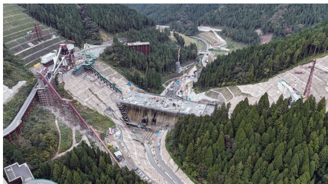
足羽川ダム（上流より）
