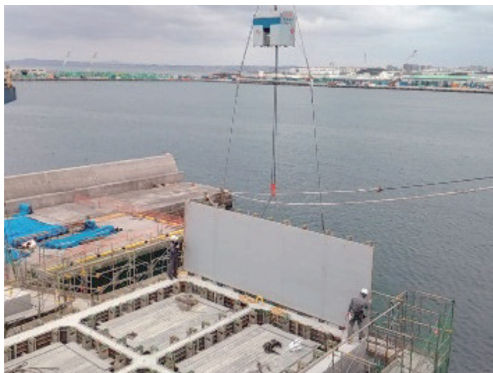
吊治具【ちょー転】(型枠垂直時)
