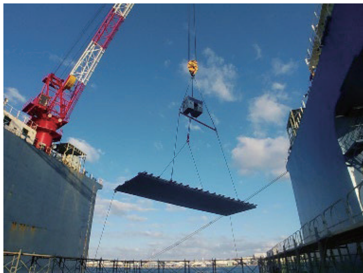
吊治具【ちょー転】(型枠水平時)
