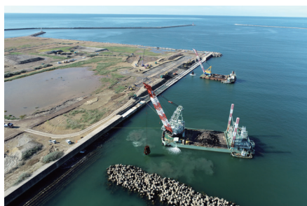
基礎捨石撤去状況
