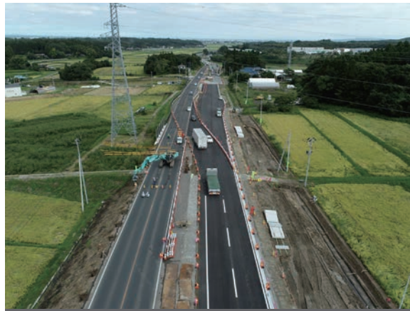
【国道4号 大衡道路】現道交通を切廻しながら工事推進
