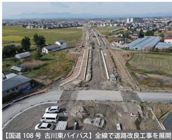
【国道108号 古川東バイパス】全線で道路改良工事を展開
