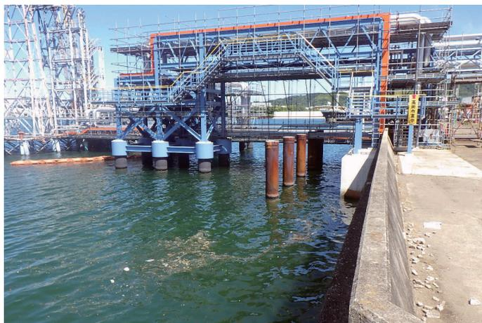
本工事は、和歌山下津港海岸（海南地区）藤白護岸における津波対策として護岸の天端高を高くするため、構造物撤去工、本体工（鋼管杭）、本体工（ケーソン式）、基礎工、排水構造物、仮設工、雑工を行うものです。
