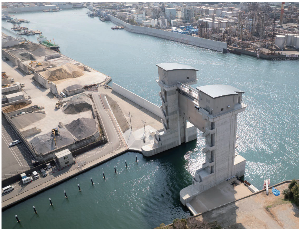
和歌山下津港海南地区 港奥部の整備状況
