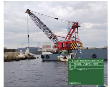
図-3 消波ブロック据付状況
