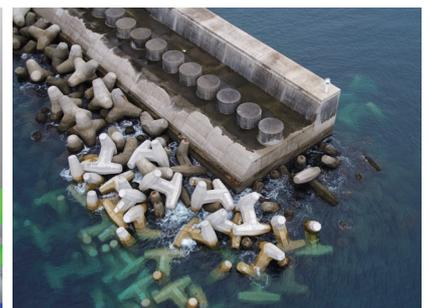
図-5 消波ブロック据付完了状況
