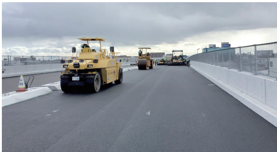
舗装状況写真
