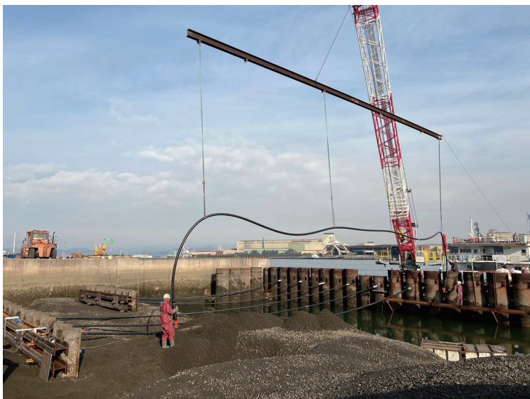
控工 タイ材取付
