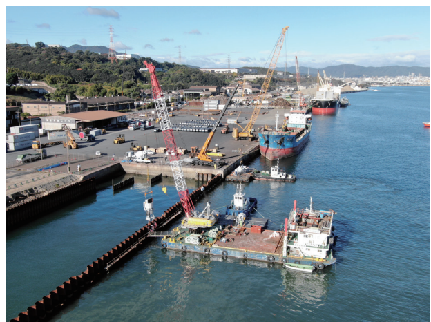
中詰コンクリート打設
