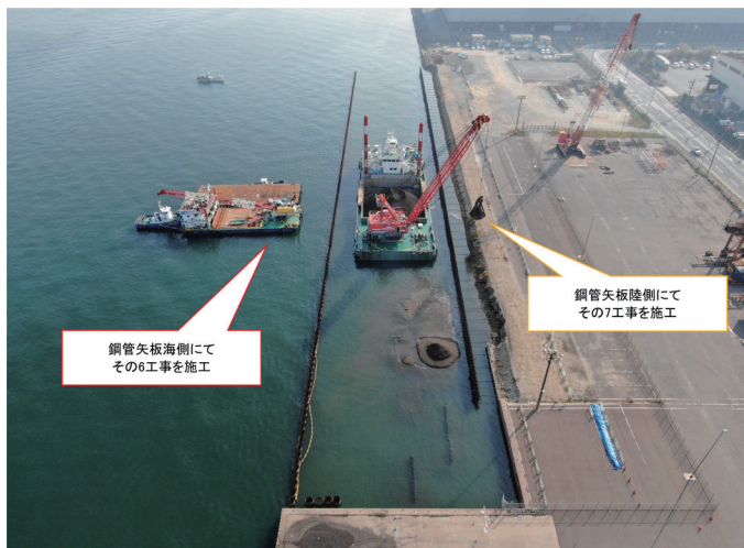
杭頭処理・裏込投入：同時併行作業
