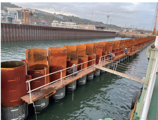
鋼管矢板切断
