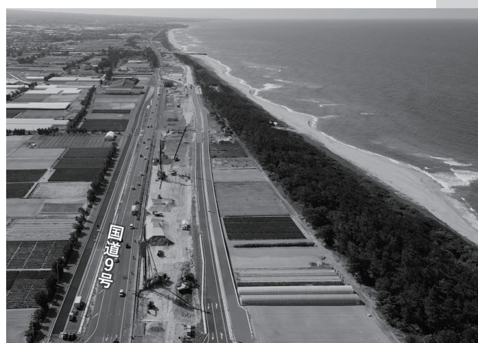
北条道路施工状況（地盤改良工）
