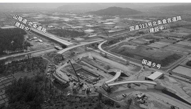
北条 JCT 橋梁上部施工状況
