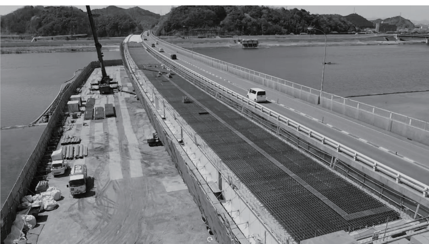
米子道路付加車線施工状況（橋梁上部工）
