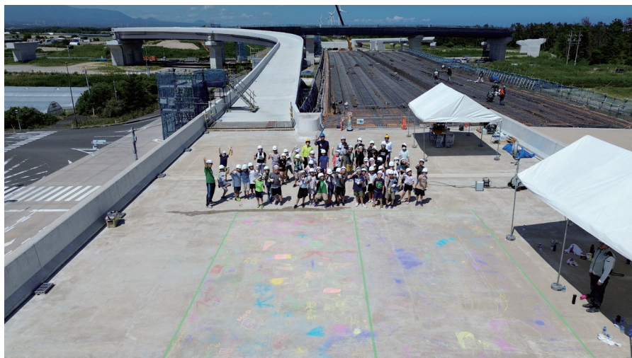
北条高架橋 現場見学会
