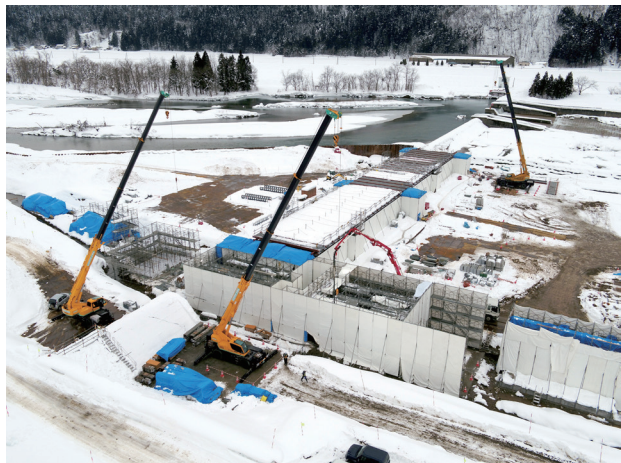
堰軸右岸から（R7.2月）
