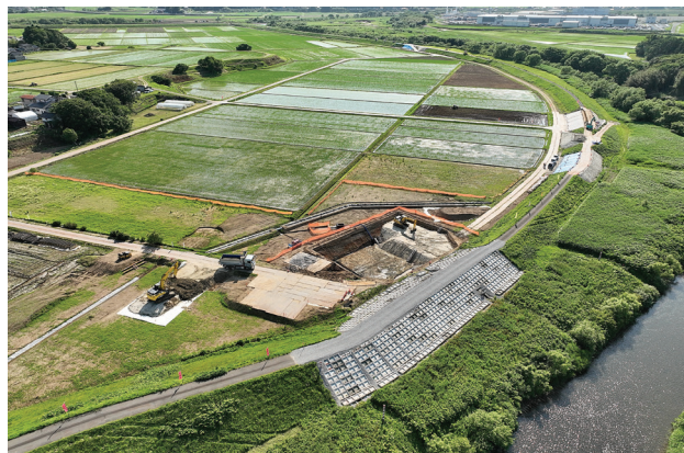
堤防決壊した石沢川鮎瀬地区の施工状況
