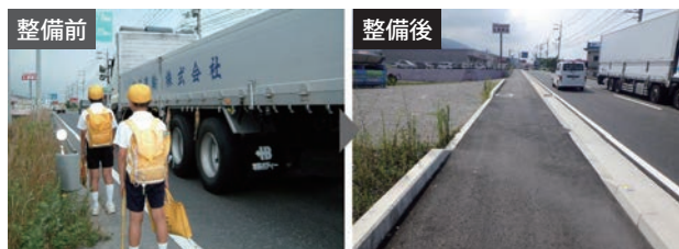
歩道整備 ～国道 11 号 四国中央市豊岡町長田～
