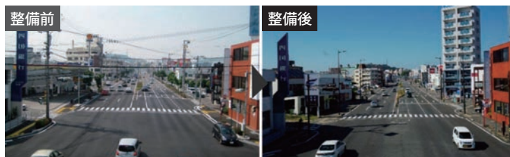
電線共同溝の整備による無電柱化 ～国道 11 号 小坂地区（松山市）～
