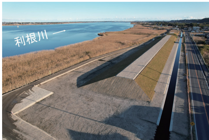
図2 堤防整備の状況（森戸町地区）
