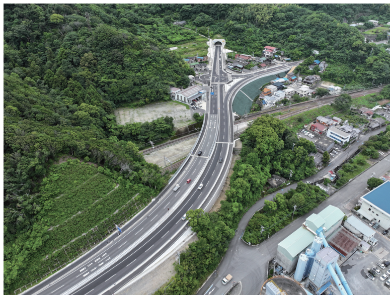
(冷水拡幅・有田海南道路)【終点側】冷水地区
