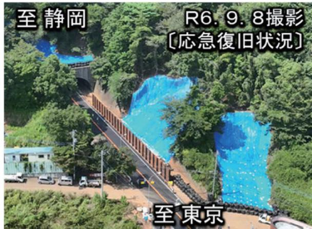
国道246号 新善波トンネル土砂崩落の応急復旧の状況
