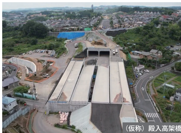
(仮称) 館高架橋
