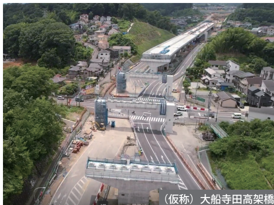
(仮称) 館第二トンネル
