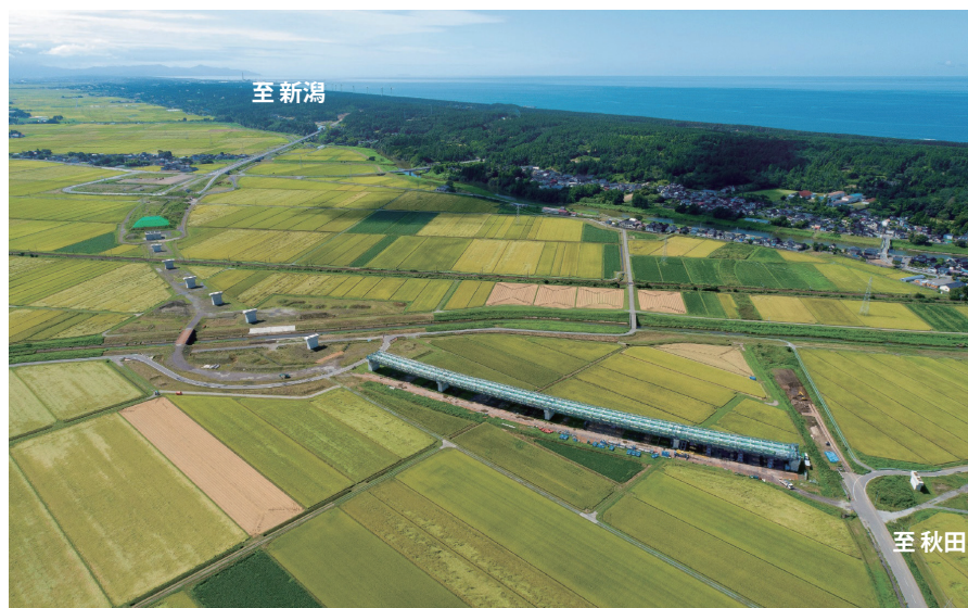
遊佐象潟道路 (仮称)吹浦高架橋
