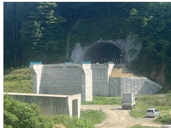
朝日温海道路（仮称）小岩川第2トンネル
