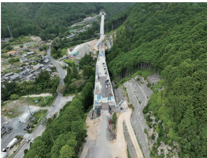
三遠道路（新城地区） 飯田市方面を望む
