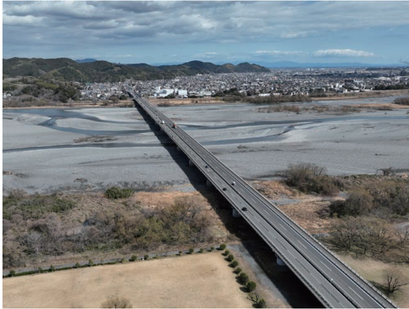
国道1号 島田金谷バイパス（新大井川橋） 藤枝市方面を望む
