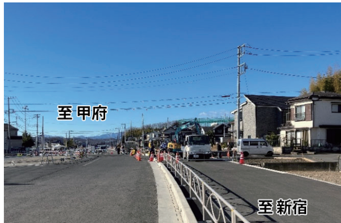
[写真 2] 日野バイパス（延伸）[川辺堀之内地区改良]
