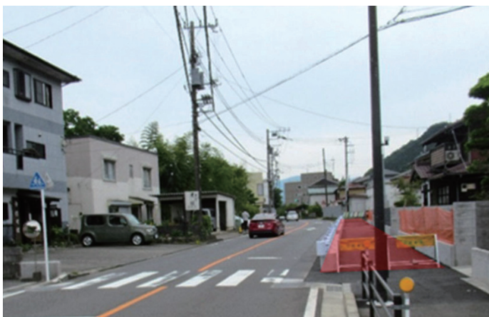
[写真 3] 藤野地区周辺歩道整備
