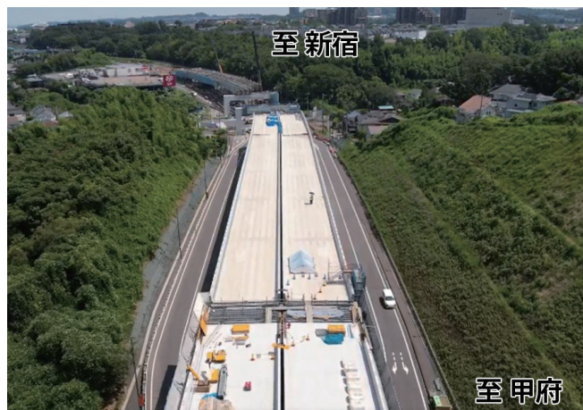
〔写真1〕八王子南バイパス〔大船寺田高架橋〕
