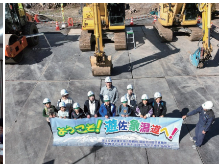
協議会による現場安全点検
