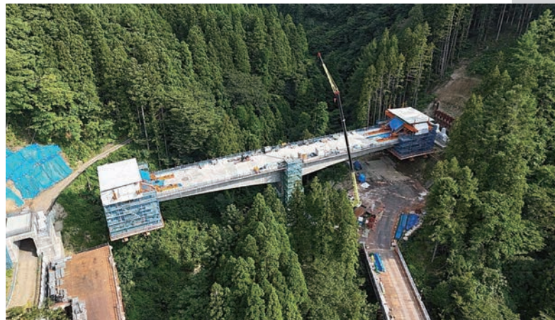
湯野上バイパス（仮）4号橋（下郷町）
