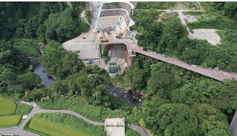
湯野上バイパス（仮）2号橋（下郷町）
