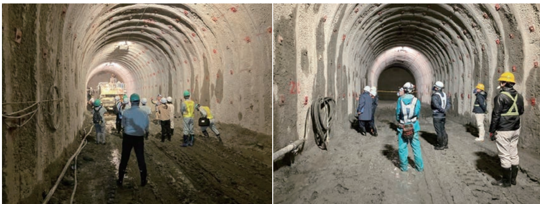
協議会パトロール実施状況
