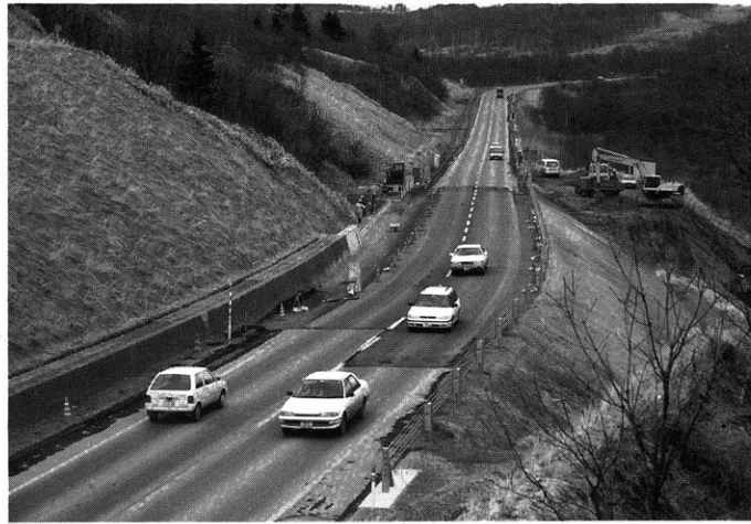
一般国道44号厚岸町糸魚沢道路災害応急復旧工事 (工期 H5.1.27~H5.3.25)
