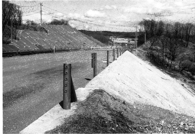
一般国道38号白糠町馬主来道路災害復旧工事 (工期 H5.2.19~H5.3.29)
