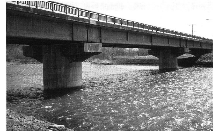
一般国道240号阿寒町松之恵橋災害応急復旧工事 (工期 H5.1.27~H5.2.26)
