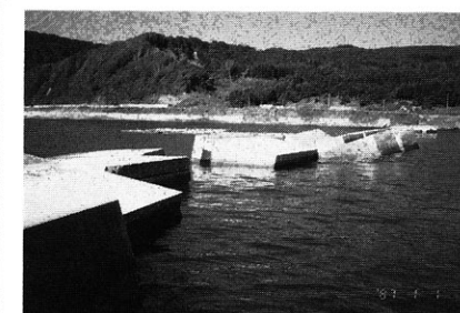
▲奥尻港北防波堤
