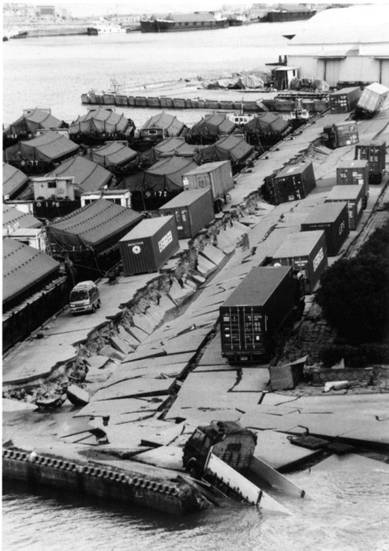
摩耶埠頭の岸壁の9割以上が補修が必要
