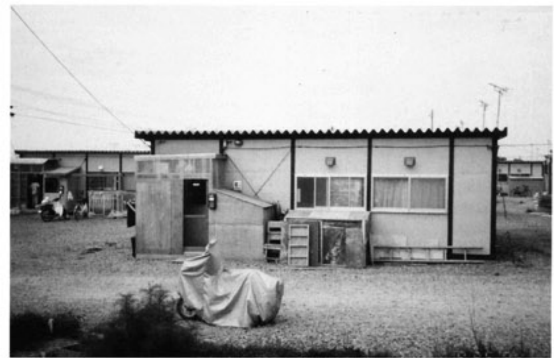
▲青苗地区仮設住宅 1994年8月25日
