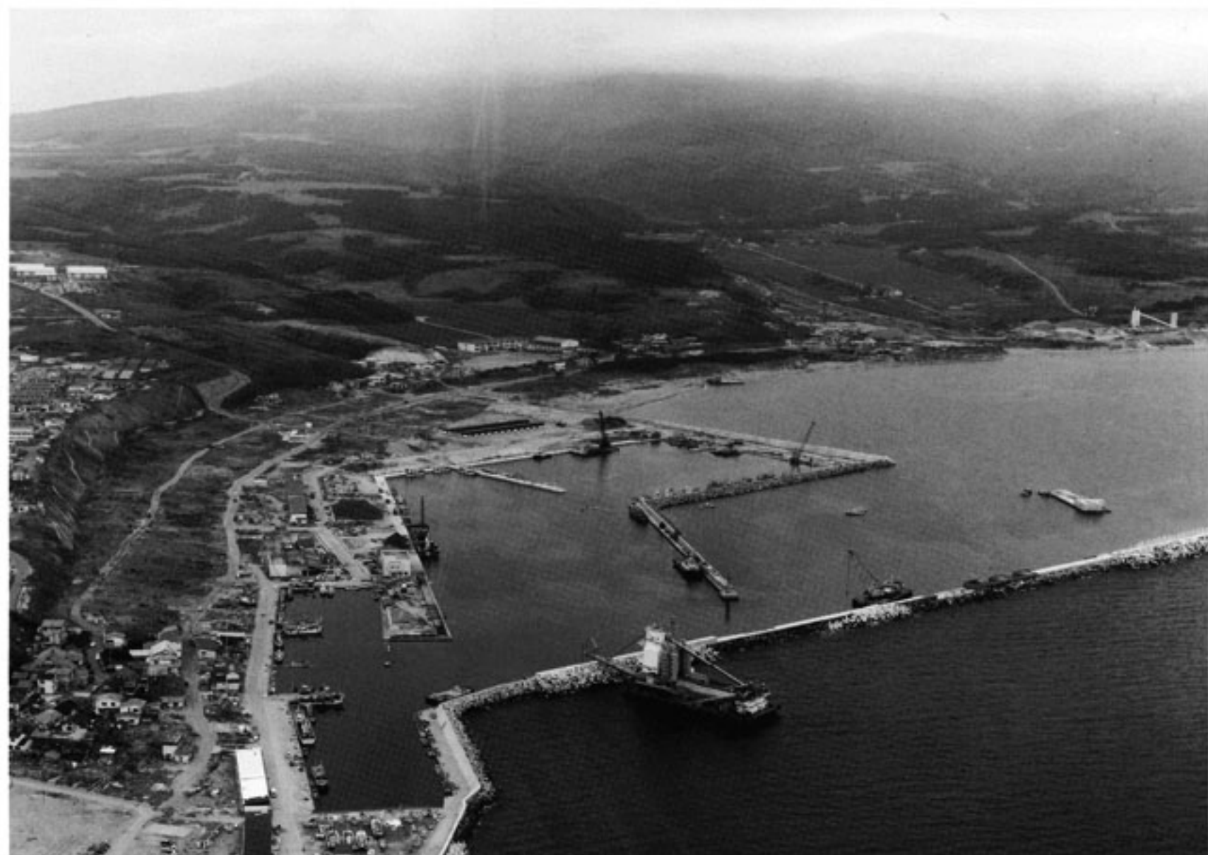
▲上空から見た青苗漁港 工事最盛期の様子がうかがわれる。1994年夏
