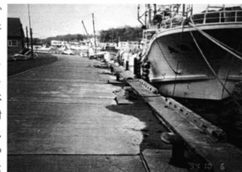
▲散布漁港 物揚場の沈下
