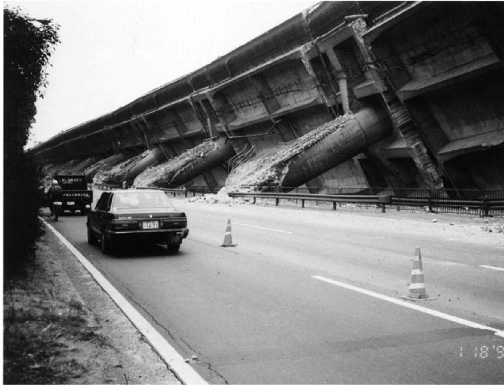
▼橋脚が連続して倒れている
