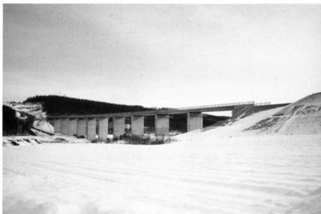
▲北明橋の全景
