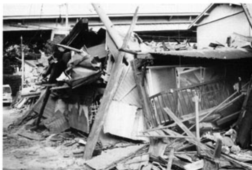
▲民家の破損状況 (写真提供: 札幌市消防局)
