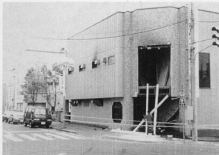
▲根室市 飲食店ビルにおける火災（緑町カッコー会館）
