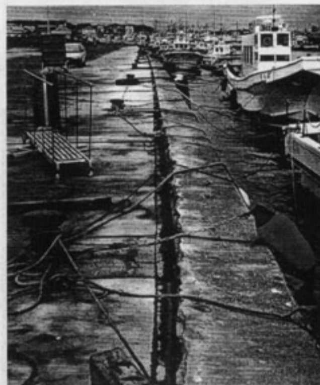
▲岸壁の破損
